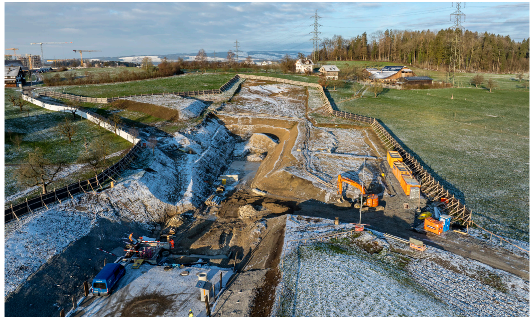
Hauptlos Ost – Tunnelbau Städtlerwald: Das Portal Stumpfen (im Bild) wird vom Knoten Duggeli erschlossen. Hier ist die künftige Tunneleinfahrt bereits erkennbar.
