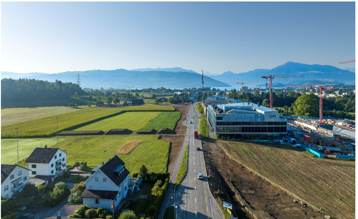
Knonauerstrasse mit Blick vom Pfad in Richtung Cham.
